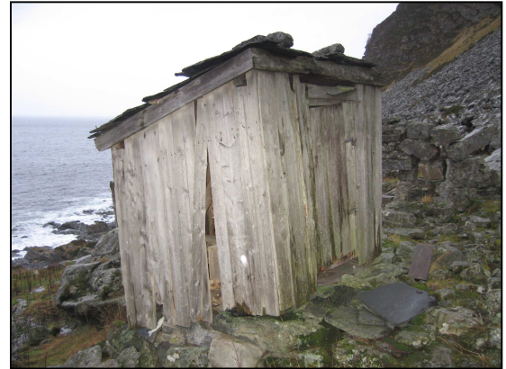
Slik var tilstanden, både ute av lodd og litt «vridd».
