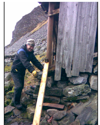
Slik var tilstanden, både ute av lodd og litt «vridd».
