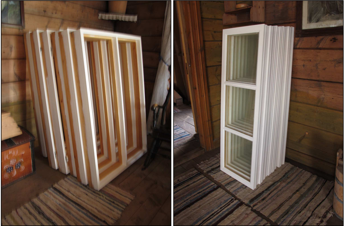
Her er dei sju karmene på plass og glasfag til dei same. Alle er nøyaktige kopiar av dei som vart fjerna på 1970-talet. Hengsler og hasper er også originale.
